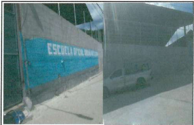
Foto 4: Pintura de muro de interior y exterior lineal (tipo L).
