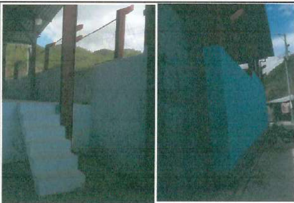
Foto 3: Pintura de muro de interior y exterior lineal (tipo L).
