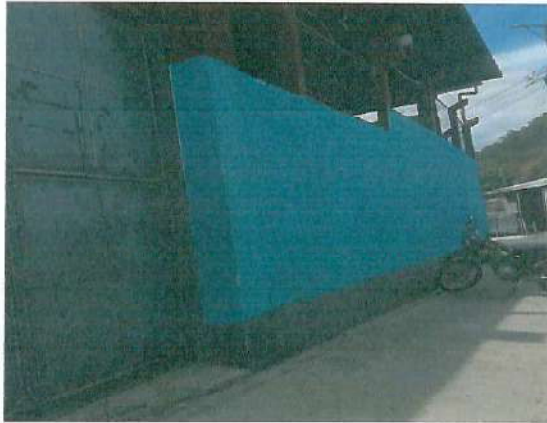
Foto 1: Reparación del Muro de contención en entrada No.2.
